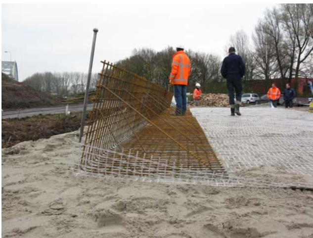
systemopbouw grondkerende constructie voor A2 Hooggelegen
