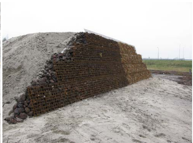
systemopbouw grondkerende constructie voor A2 Hooggelegen
