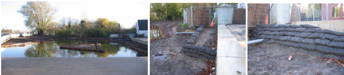
Diverse grondwallen bouwen bij buitenpodium theater 'De Effenaar'. Opdrachtgever en ontwerp Gemeente Eindhoven.
